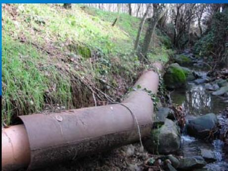
Tracciato collettore fognario attualmente in alveo (a seguito di erosione di sponda)
